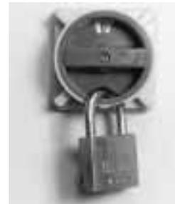
Figure 1: interrupteur de sécurité protégé par un cadenas personnel.
