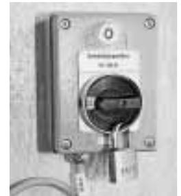
Figure 2: interrupteur de sécurité avec indication de la partie de l'installation qu'il déclenche.
