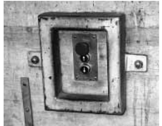
Figure 7: boîtier de commande équipé d'un interrupteur d'arrêt d'urgence et d'un cadre de protection contre les chocs.
